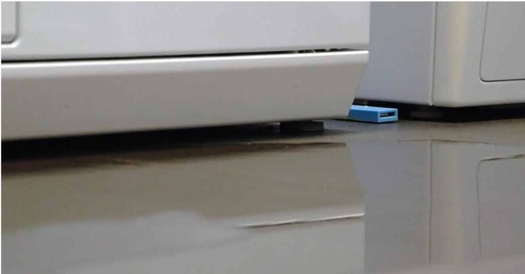
Verwendet für den technischen Alarm, kann der Wassersensor vor Unheil bewahren. Die meisten Geschirrspüler haben diese Funktion beispielsweise bereits eingebaut und schalten bei einem Fehler die Wasserzufuhr ab. Der Wasseralarm schützt jene Räume im Haus, wo Wasser im Einsatz ist und durch einen Bodenabfluss nicht ausreichend abfließen kann.
