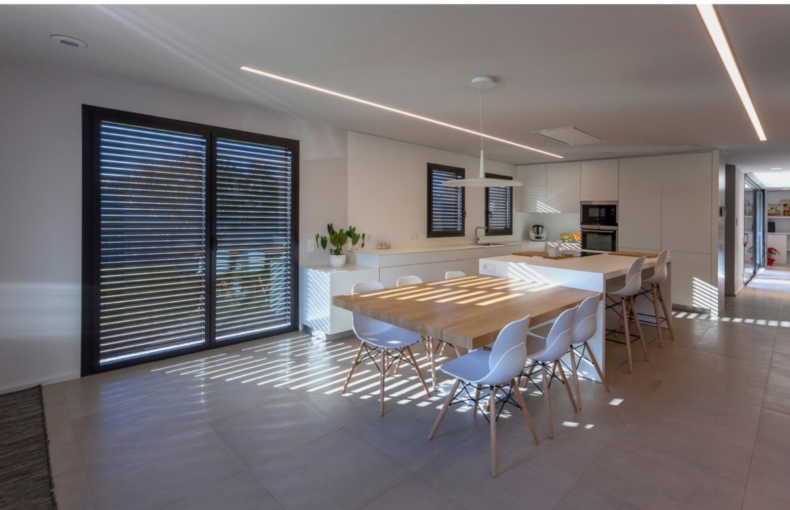
Raffstore sind je nach Größe anfällig gegen Wind und Vereisung im Winter. Darum sind gewisse Sicherheitseinrichtungen notwendig um die Beschattung zu schützen. Diese Einrichtungen sind in einem Real Smart Home selbstverständlich vorhanden. Die Ausführung was das Design der Lamellen angeht und auch die Farbgestaltung ist vielfältig, die Farbe sollte das Sonnenlicht möglichst zu reflektieren.
